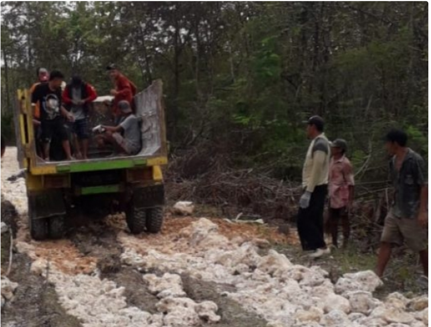
Giat Satgas TMMD Kodim 0721/Blora Keraahkan Dump Truck Untuk Angkut Material. Senin, (09/05/2022).
